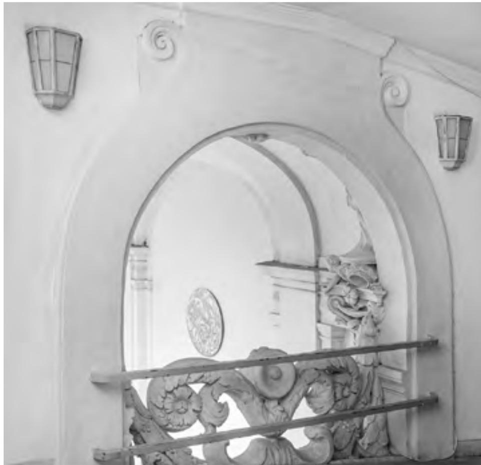
La straordinaria soluzione plastica del fregio nasconde un aspetto costruttivo, ovvero il passaggio della rampa elicoidale alle sue spalle e la frattura nel muro per consentirne l'illuminazione.
