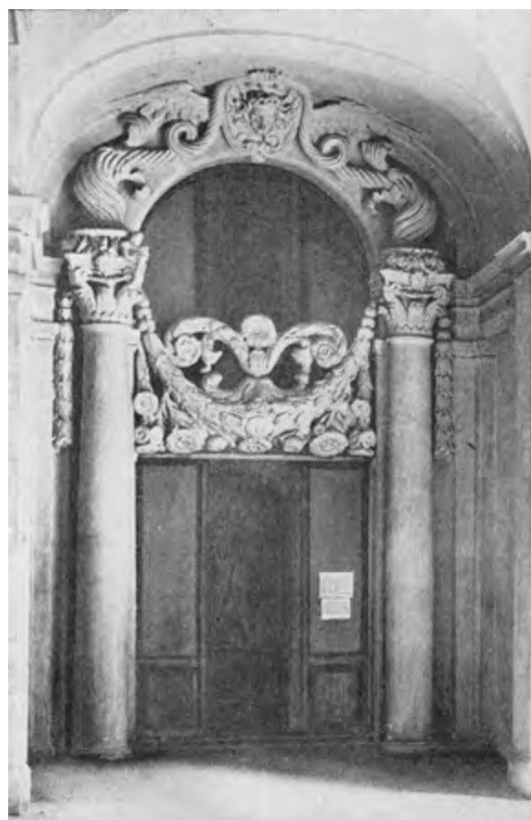
13. Il portico di Palazzo Carpegna, 1926 circa. Si noti, tra gli archivolti del portico di Borromini, la presenza di un secondo ordine di arcate verso il cortile.
