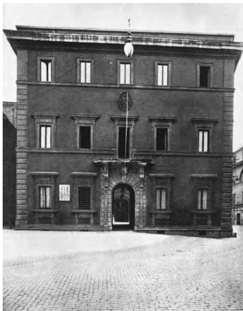
33. Palazzo Carpegna, sede della Reale Insigne Accademia di San Luca, aprile 1934. Il prospetto principale.
