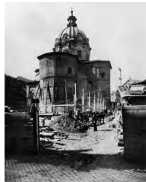
7-9. Demolizioni degli edifici intorno alla chiesa dei Santi Luca e Martina (1932-1933).
