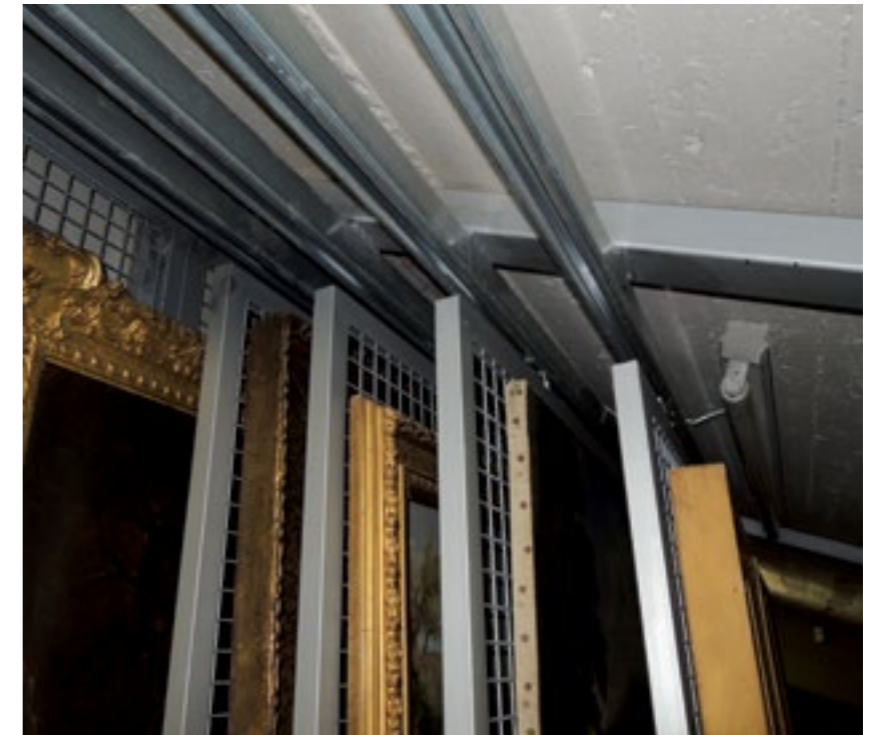
Particolare dell'ancoraggio dei pannelli metallici scorrevoli alle guide fissate al solaio in cemento armato.
