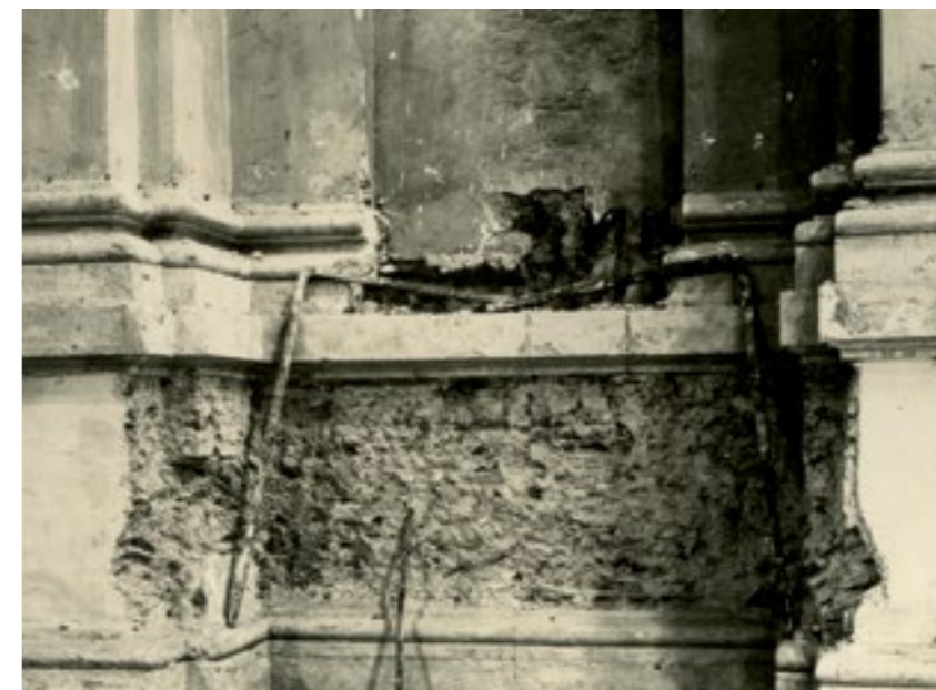
Il muro della chiesa dei Santi Luca e Martina dopo la rimozione di uno dei due gessi.
