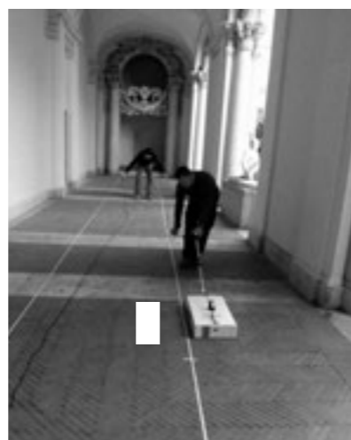
Esecuzione delle indagini – zona A.
