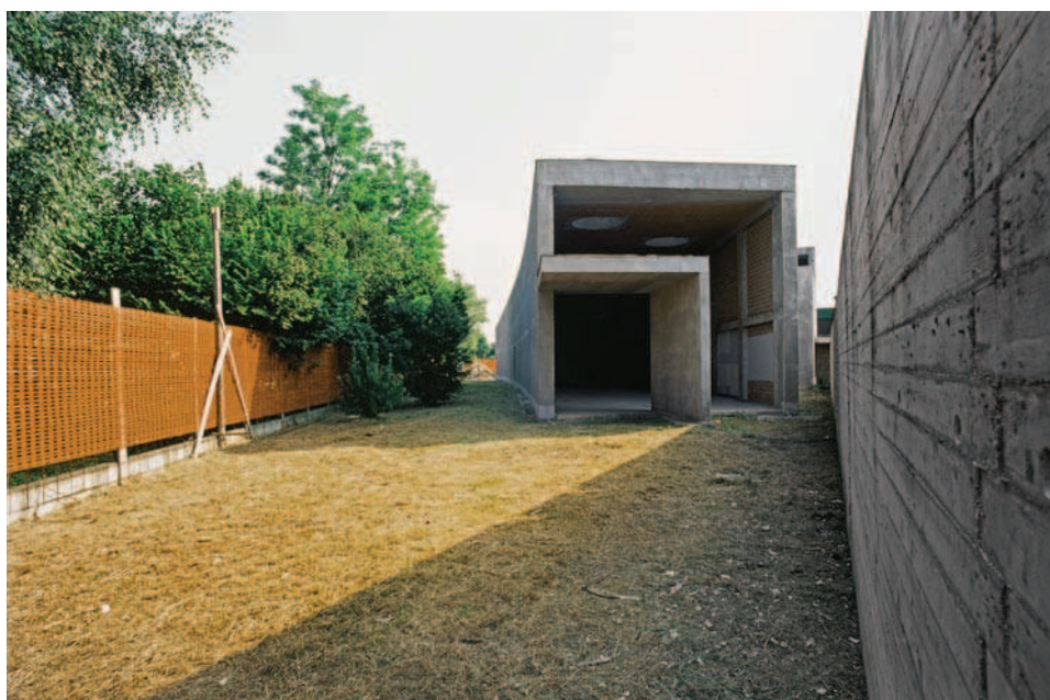
In alto: edificio in rustico, vista dell'ingresso. In basso: vista dal "giardino delle sculture". Fotografie di Alessandra Chemollo, 1995.
