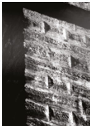
3. Narni, ponte di Augusto, prima pila da sinistra, intradosso dell'arco. Foto dell'autrice.
